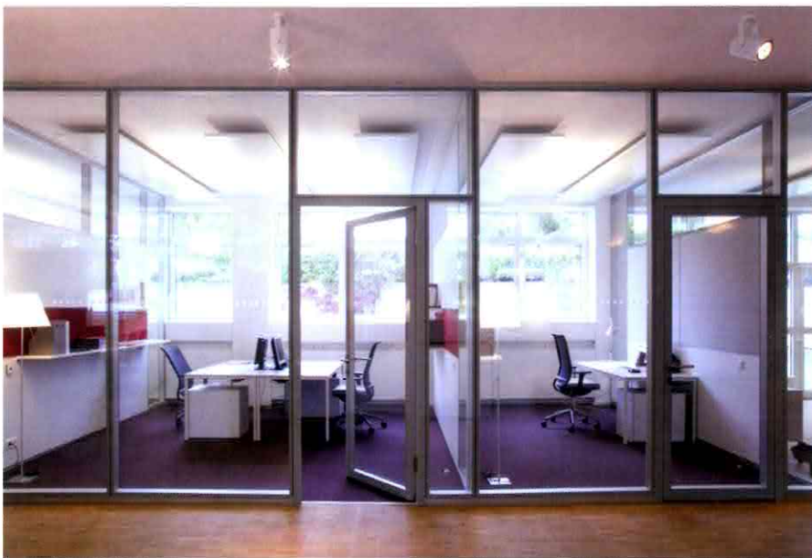
▲ Flächenbündig in die Bürozwischenwände integrierte Absorber verbinden sehr guten Schallschutz mit hoher Schallabsorption
